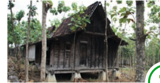
Abriss des Holzhauses
