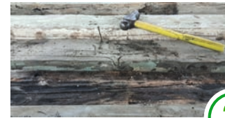
Entfernen von Nägeln, Schrauben und anderen Verbindungselementen
